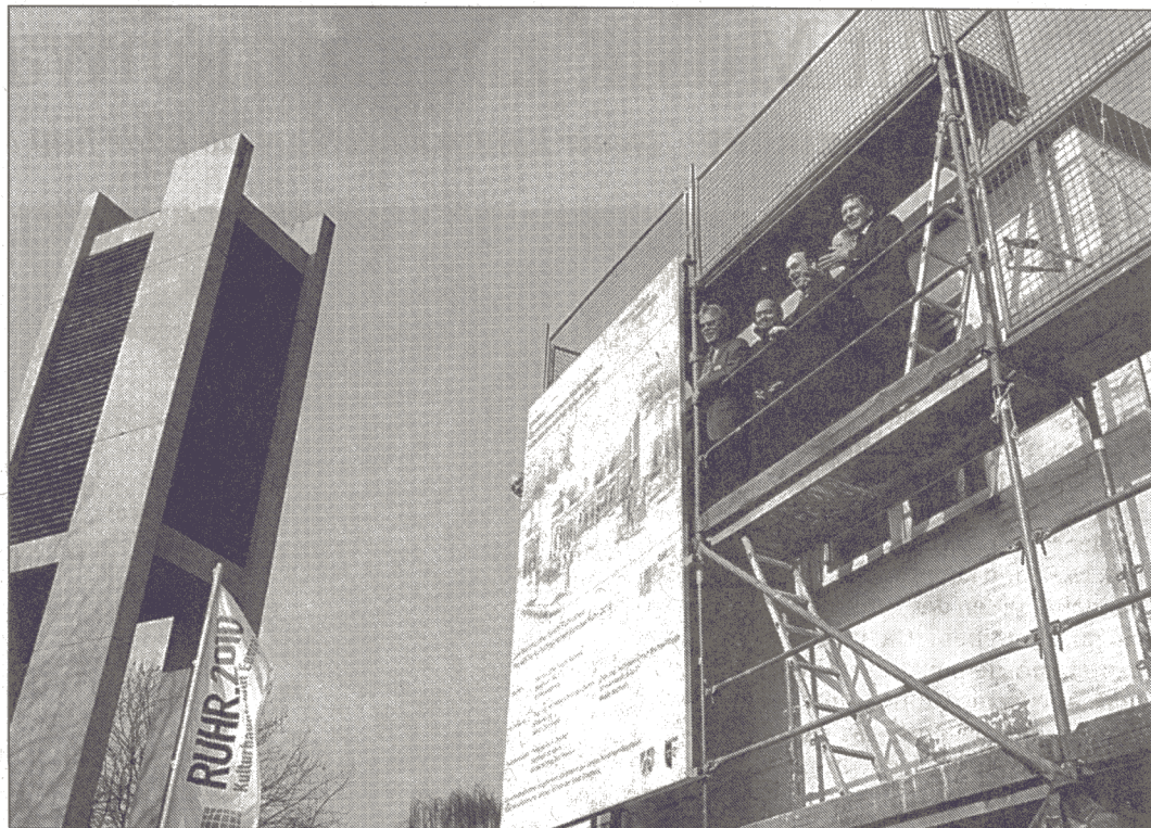
Weithin sichtbar: Das Bauschild am Martin Luther Forum Ruhr.
