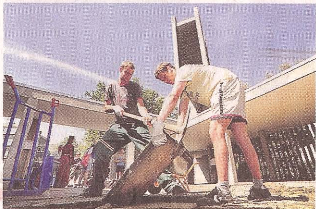
Hacken, Schieben, Schleppen: Albert (l.) und Zoltan verbringen ihre Ferien auf der Baustelle. Fotos (2): Jo Kleine-Büning
