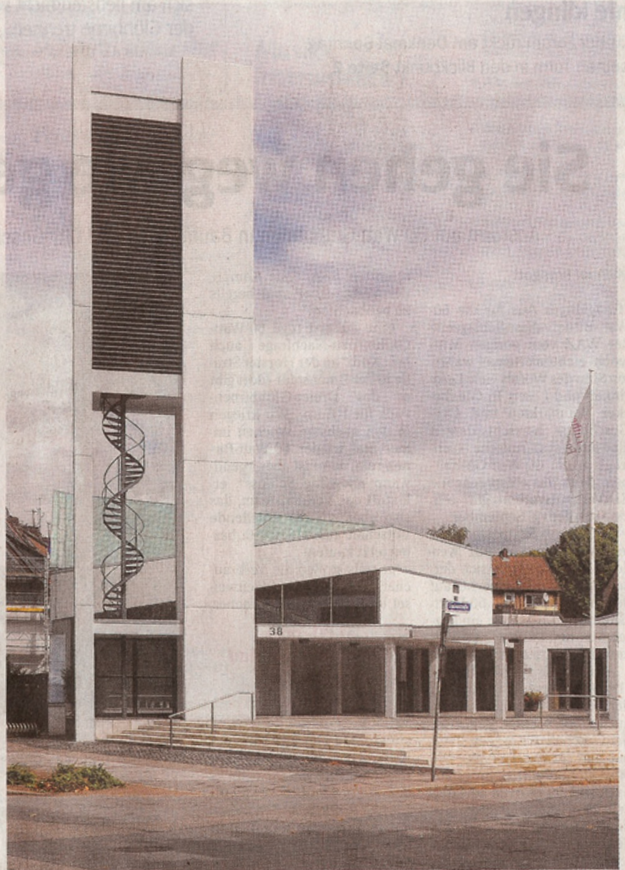
Nun ist auch der Turm saniert: das Martin Luther Forum an der Bülser Straße.
