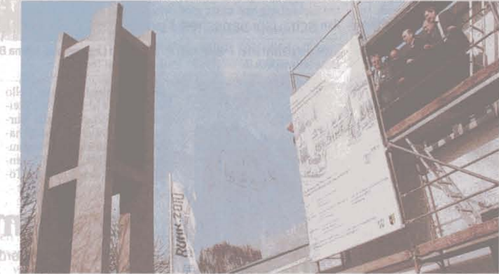
Das Bauschild ist enthüllt - nun geht es an den Umbau der Markuskirche.
