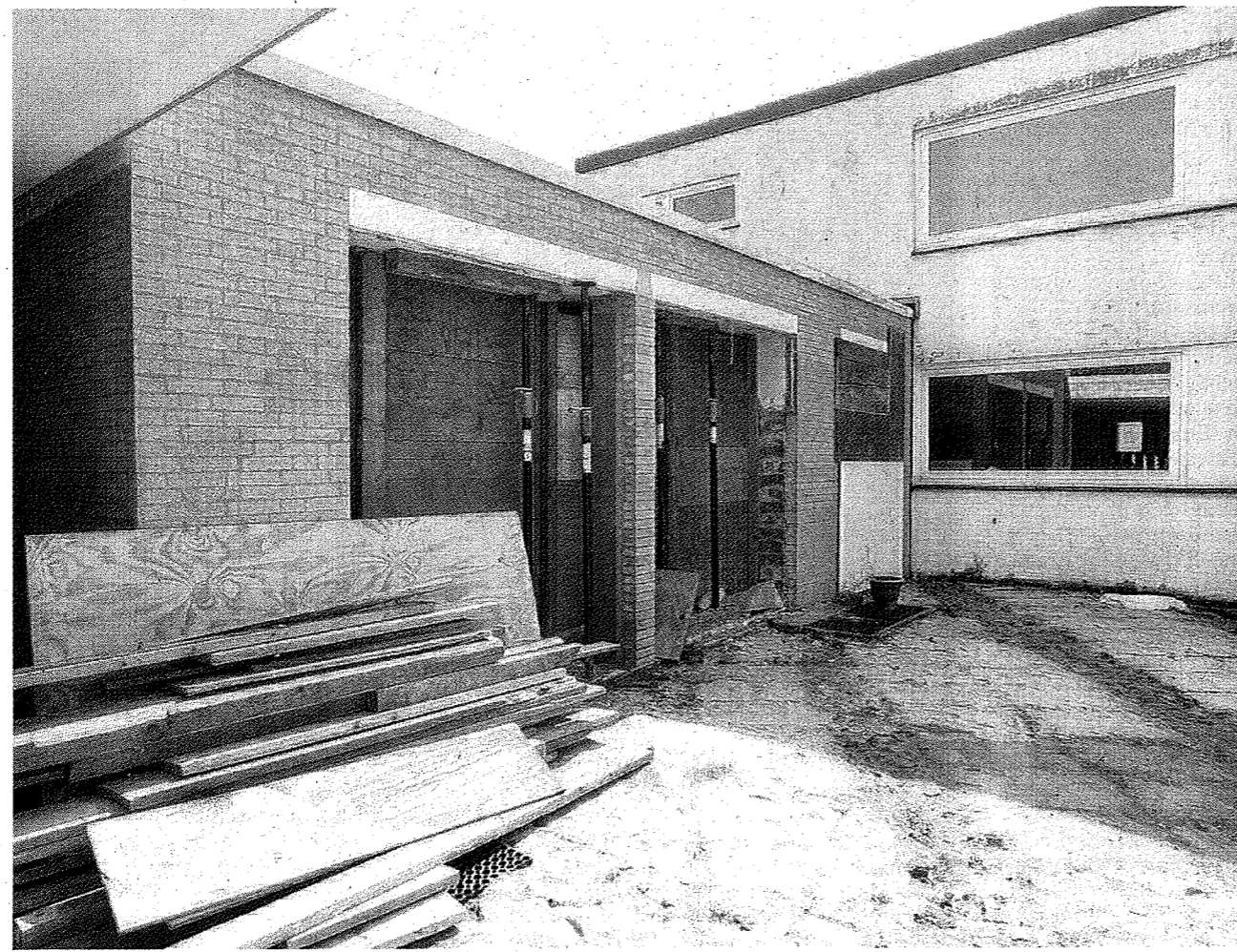
Einblicke in das Baustellen-Leben an der Bülser Straße: Zahlreiche interessierte Bürger nutzten am Samstag die Gelegenheit, sich auf dem Areal und in den Räumlichkeiten der im Mai 2008 geschlossenen ev. Markuskirche umzusehen. Foto: Dennis Straßmeier
