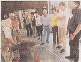
Reges Interesse – Baustellen-Führung am Martin Luther Forum Ruhr (ev. Markuskirche, Bülser Straße) am 22. August. Foto: Straßmeier
