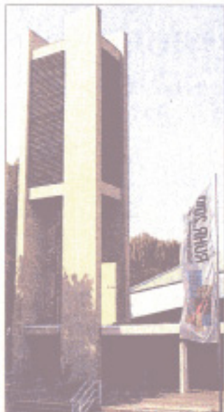
Neue Bestimmung für die stillgelegte Gladbecker Markuskirche: Sie ist jetzt ein Kulturzentrum.
