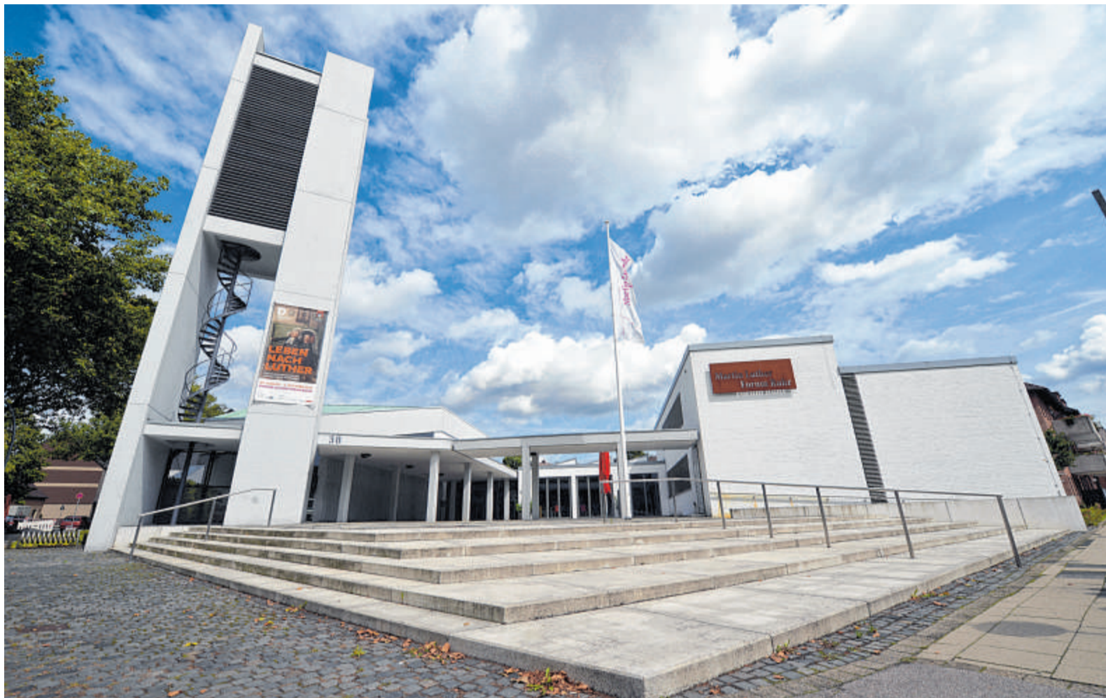
Weit über die Stadtgrenzen hinaus hat das Martin Luther Forum an der Bülser Straße einen Ruf erworben. Übrigens auch wegen der gelungenen Neunutzung der ehemaligen Markuskirche in Gladbeck-Ost an der Bülser Straße.
